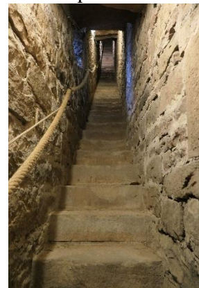
3) Aufstieg zum Dachstuhl
